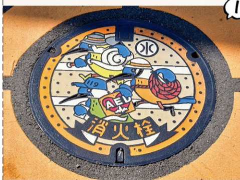
カラフルな消火栓のふた / 静岡市の消防キャラクター「かけつけ消防3部隊カワセミーズ」が描かれています。マンホールのふたにもカラフルなものがありますね。
