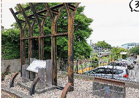
旧上原跨線橋
